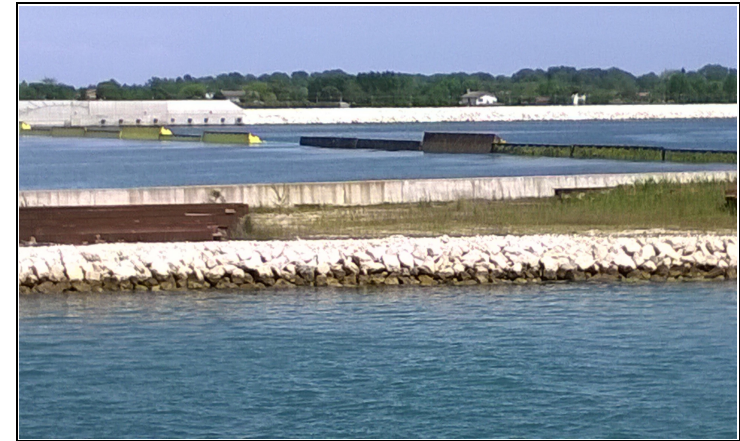
Le paratoie mobili alla bocca di porto del Lido
